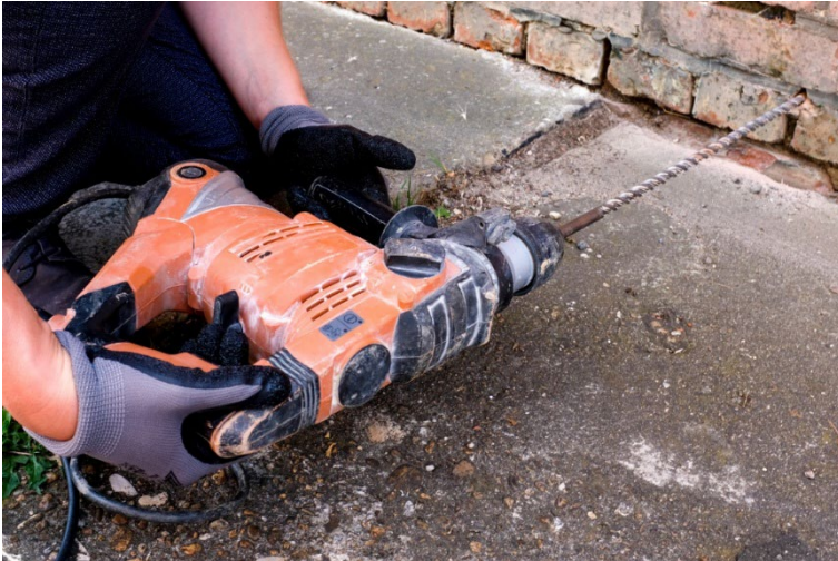
Abbildung 12: Bohrlochabstand und waagrechte Bohrung
