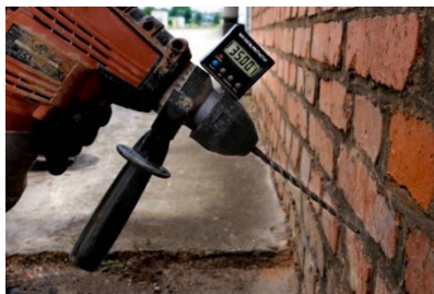
Abbildung 3: Bohren beim Schrägbohrverfahren
