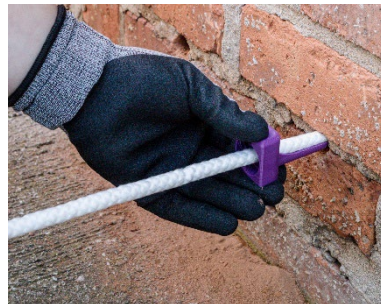
Abbildung 15: Schraubwinkel setzen
