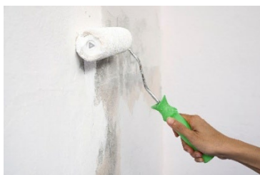
Abbildung 18: Sanierfarbe aufbringen
