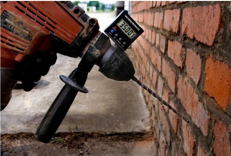
Abbildung 7: Bohrlochabstand und 35°-Winkel
