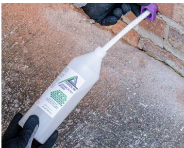
Abbildung 16: Flasche anschrauben
