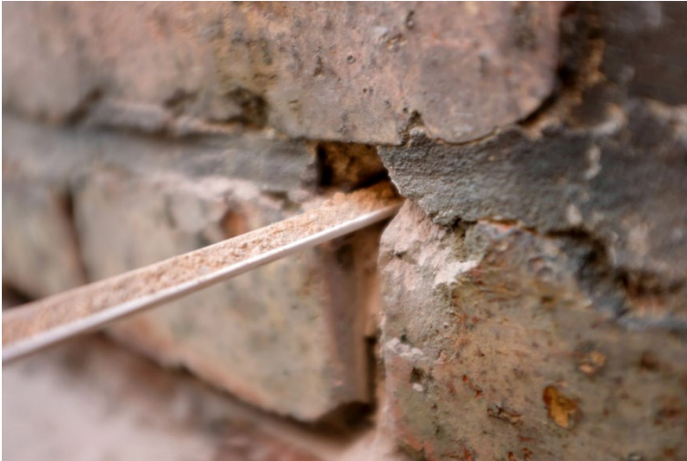
Abbildung 13: Bohrlochreinigung mit Kunststoff-Halbrohr
