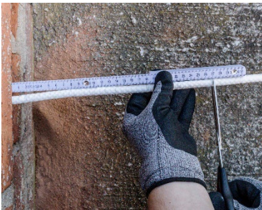
Abbildung 14: TOBOSTICK einführen
